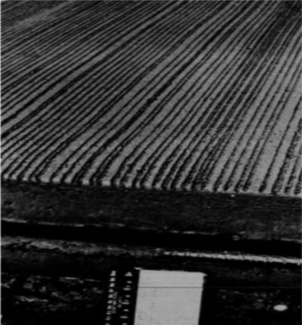
Hình 5. Hình ảnh bề mặt mặt đường sau khi được tạo nhám bằng kết cấu kỹ thuật wire comb tại sân bay Patrick Henry, Virginia với cấu trúc sử dụng 1/8 inch x 1/8 inch x 1/2 inch (wire comb technique constructed at Patrick Henry Airport, Virginia, using a 1/8 inch x 1/8 inch x 1/2 inch configuration)
