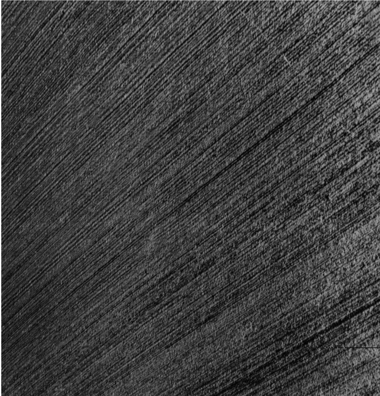
Hình 3. Hình ảnh bề mặt mặt đường mềm sau khi được tạo nhám bằng chổi máy (heavy paving broom finish)
